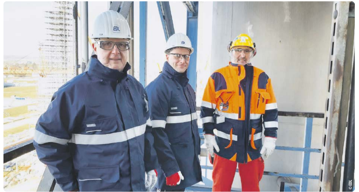
Safety Walk Audit in der Gunvor Raffinerie Ingolstadt: Raffinerieleiter Ralf Seid und EDL-Geschäftsführer Daniel Oryan überzeugten sich während des Baus der Rauchgasentschwefelungsanlage von der Einhaltung des HSSE-Managementsystems.
