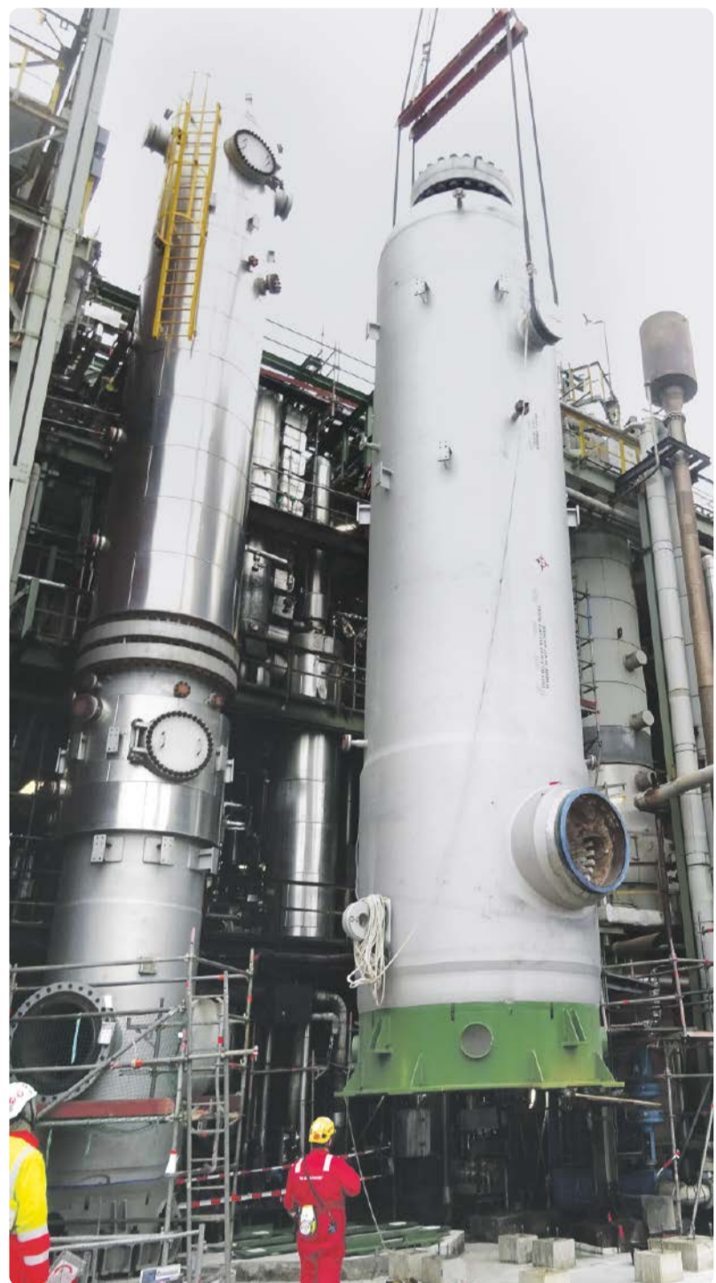
Einhub eines Vergasungsreaktors unter beengten Platzverhältnissen bei der TotalEnergies Mitteldeutschland Raffinerie in Leuna.
