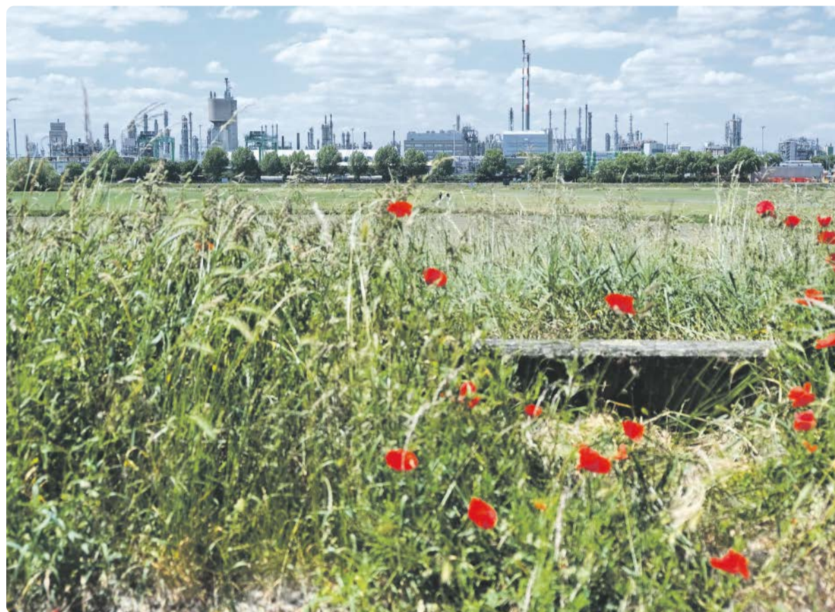
Blick Richtung Friesenheimer Insel: Hier befindet sich eines der BASF-Areale, für das die Schuler Service Group zuständig ist. Es handelt sich um ein Tanklager mit einer Gesamtfläche von rund 154.000 m 2 und strengsten Feuer- und Brandschutzbestimmungen.
