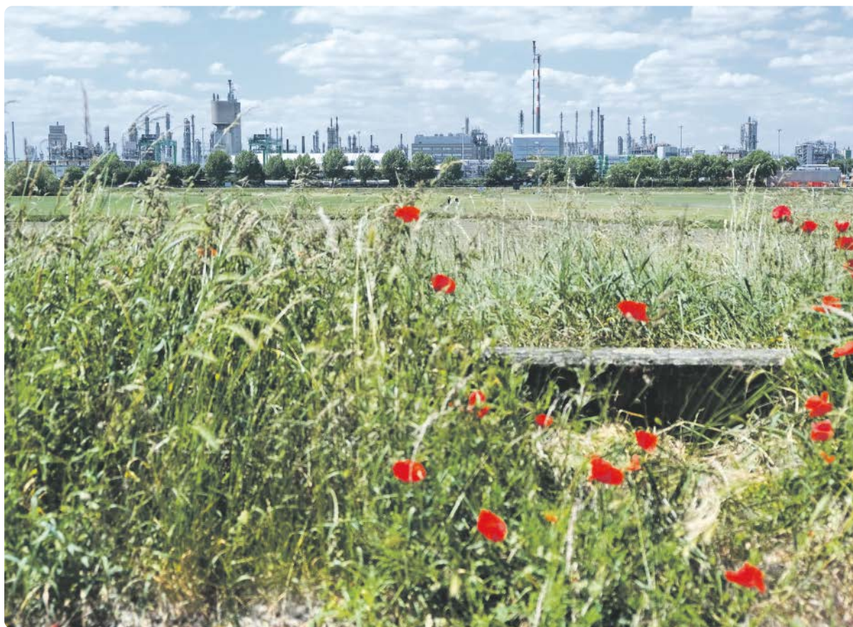
Blick Richtung Friesenheimer Insel: Hier befindet sich eines der BASF-Areale, für das die Schuler Service Group zuständig ist. Es handelt sich um ein Tanklager mit einer Gesamtfläche von rund 154.000 m 2 und strengsten Feuer- und Brandschutzbestimmungen.
