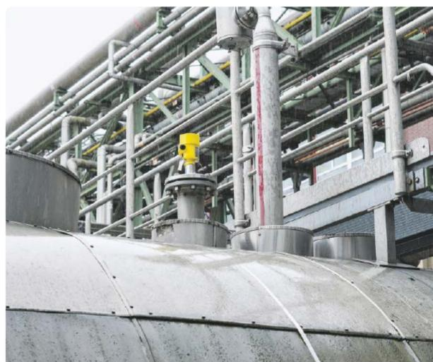
Der Einsatz des Vegapuls 6X ist vielfältig: Im Außenbereich der MMA-Anlage misst er bei Röhm die Füllstände zweier jeweils 30 m<sup>3</sup> fassender Tanks, in denen das fertig produzierte Produkt auf die Fassabfüllung wartet.
