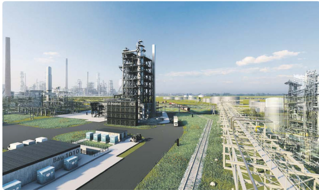
Im Shell Energy and Chemicals Park Rheinland entsteht eine innovative, CO 2 -arme Anlage zur Grundöldestillation.
