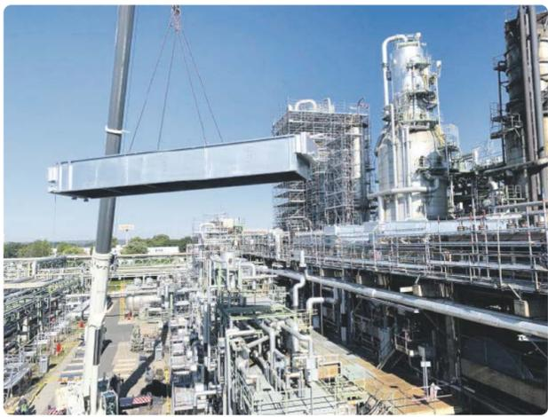
Die neue Grundöldestillation am Standort Wesseling wird mit Vakuumgasöl vom Standort Köln-Godorf versorgt. Dort wurde bereits ein neuer Luftkühler installiert.
