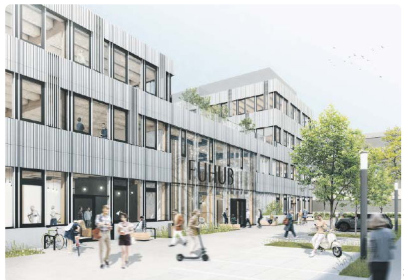
Der FU HUB der Freien Universität Berlin in Berlin-Dahlem ist der erste spekulativ entwickelte Holzhybridbau im Laborbereich in Deutschland. Er kombiniert flexibel nutzbare Laborflächen mit Büros und Konferenz-, Co-Working- und Kollaborationsräumen. Die Labore sind flexibel für Forschungen in den Sicherheitsstufen S1 und S2 konzipiert.
