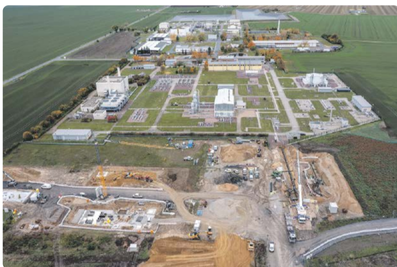
In Bad Lauchstädt befindet sich Ostdeutschlands größter unterirdischer Erdgasspeicher – in einem Teil davon soll künftig Wasserstoff gespeichert werden.
