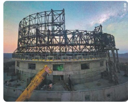
Die Beschichtung der Stahlkonstruktion, die inzwischen die für Teleskopkuppeln typische runde Form angenommen hat, spielt eine besondere Rolle, denn um das Streulicht zu minimieren und Störungen im Betrieb zu verhindern, muss sie eine möglichst tiefschwarze, stumpfmatt Oberfläche erhalten. Die ESO setzte dabei auf Lacke von WB Coat-
