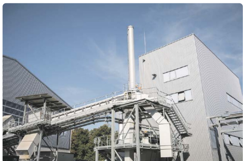
13 Mio. EUR investierte Brüggemann in das neue Bioheizwerk.
