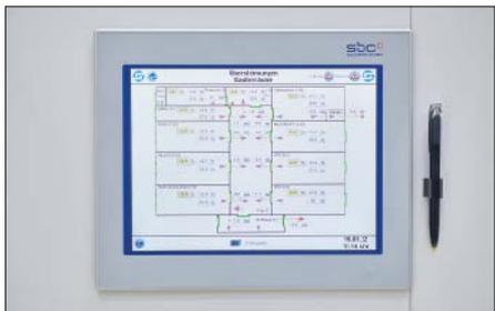
**Abb. 2:** Auf dem Steuerungstableau neben der Personalschleuse hat man jederzeit Zugriff auf alle relevanten Daten, hier insbesondere die Sicherstellung der Strömungsrichtungen bei minimierten Überdrücken.
