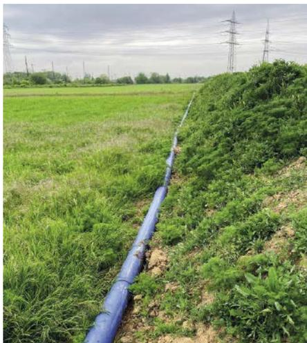
Diese zur Pumpe passenden Schnellkupplungsrohrleitungen wurden von der Hettmansperger Spezialtiefbau in Karlsruhe geliefert. Über die SK-Rohre mit ihrem Durchmesser von DN 150 wurden die 600 m<sup>3</sup> Wasser in ein Sammelbecken gefördert.
