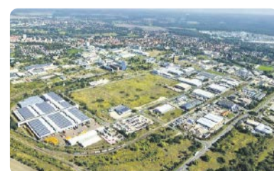
8. Chemiepark Bitterfeld-Wolfen, Deutschland
