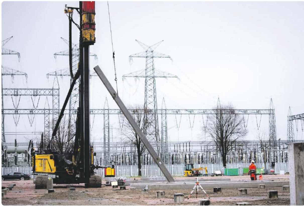
SuedLink Bauauftrag Konverter Brunsbüttel: Zunächst werden ca. 2.300 Betonpfähle für das sichere Fundament in den Boden gerammt. Dann beginnt der Hochbau.
