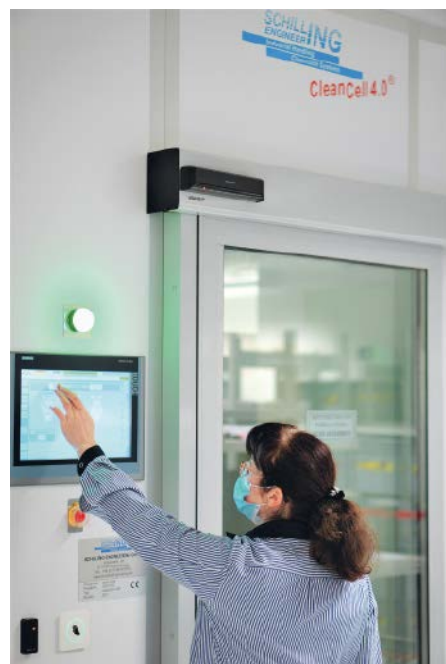
Abb. 5: Die Steuerung des Reinraums wird über Touchscreens durchgeführt. Die Oberflächen wurden ins Estnische übersetzt, um die Bedienung zu erleichtern.
