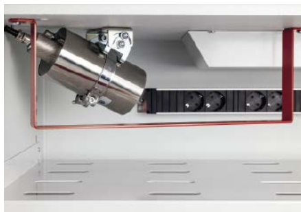
Schutzkontaktsteckdosen zum Anschluss von Ladegeräten und das Brandunterdrückungssystem.
