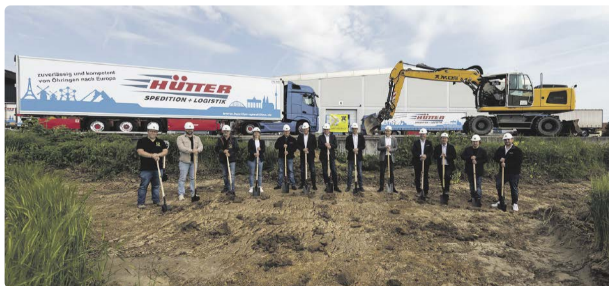
Spatenstich für das neue Hütter-Pharmalager am 15. Mai 2023.
