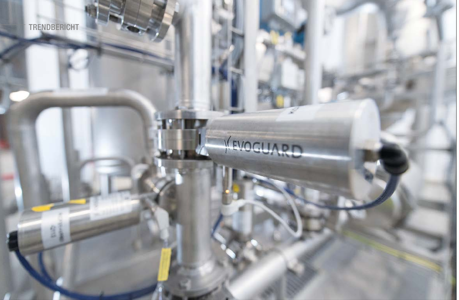
▲ Abb. 2: Rohre in der Lebensmittel- und Getränkeindustrie sind aufgrund der hohen Beständigkeit gegenüber Korrosion und Erosion aus Edelstahl rostfrei gefertigt.
