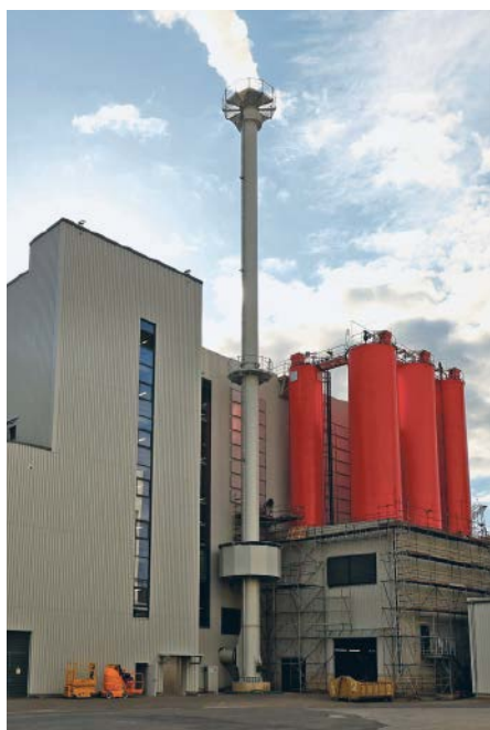
Abb. 4: Die KVA Helmstedt: Mit einer Kapazität von 160.000 t OS erzeugt sie rund 15.000 t phosphathaltige Asche. Sie wird in den vorderen beiden roten Silos für das spätere Phosphorrecycling gespeichert.
