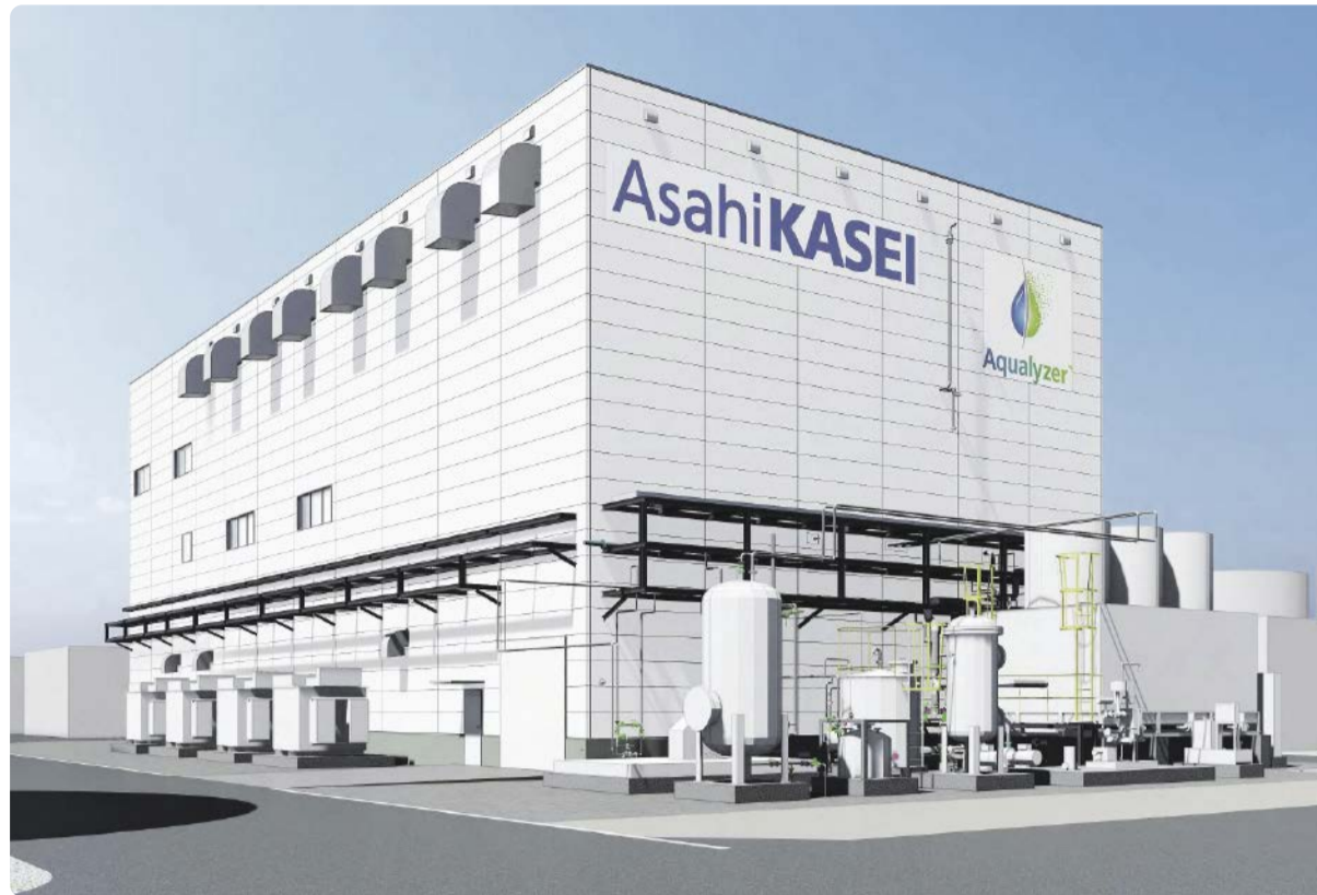
Pilotversuchsanlage für alkalische Wasserelektrolyse zur Wasserstoffherzeugung in Kawasaki, Japan.
