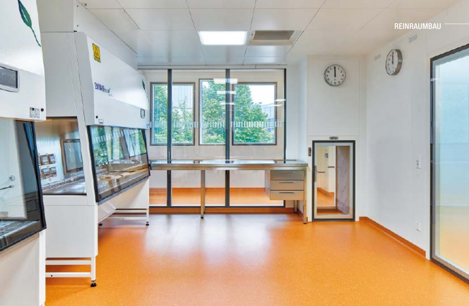
Abb. 1: Nora Kautschukböden sind durch das Fraunhofer Institut IPA hinsichtlich ihrer Eignung für Reinräume und GMP-Bereich zertifiziert.
