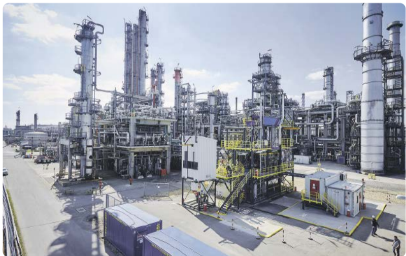
In der Raffinerie Schwechat bei Wien betreibt OMV eine Pyrolyse-Pilotanlage zum chemischen Recycling von Kunststoffabfällen. Eine Demonstrationsanlage befindet sich aktuell im Bau und soll noch dieses Jahr in Betrieb gehen.
