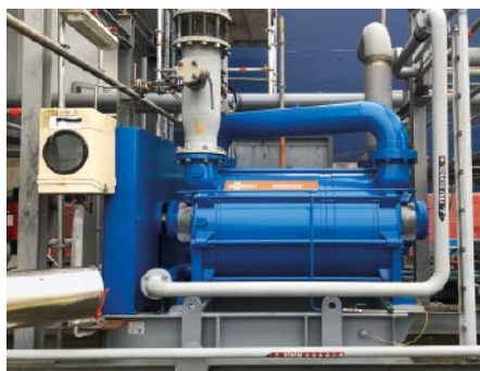
Installation der Dolphin Flüssigkeitsring-Vakuumpumpe in der Dampfdruckgewinnungsanlage im Hafen von Göteborg.
