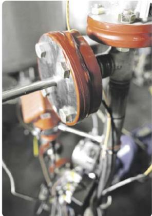
Der Henkel Loctite Pulse Smart Flange kann Leckagen frühzeitig erkennen und trägt so zur Zuverlässigkeit kritischer Anlagen bei. Zur industriellen IoT-Lösung gehört eine intelligente App, die Benachrichtigungen sendet, wenn Unregelmäßigkeiten festgestellt werden.
