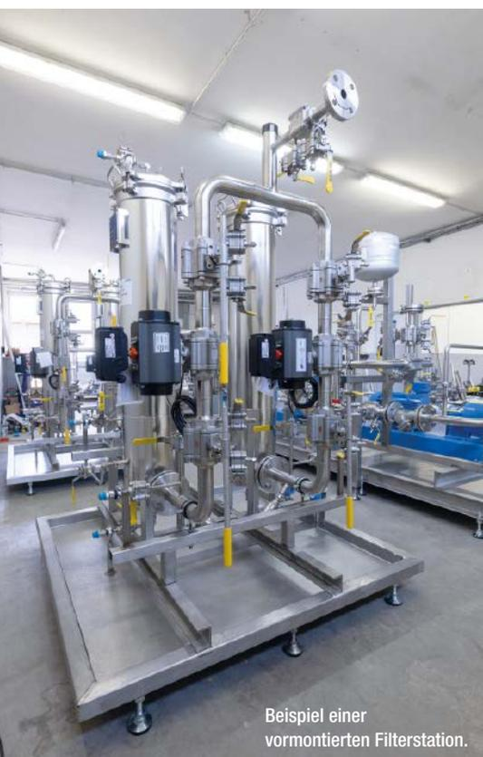
Beispiel einer vormontierten Filterstation.
