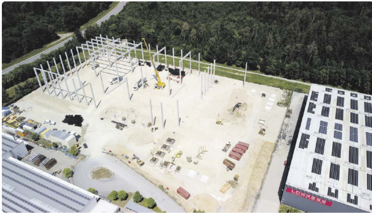
Bauprojekt von Loxness in Haiming für einen Kunden aus der Chemiebranche
