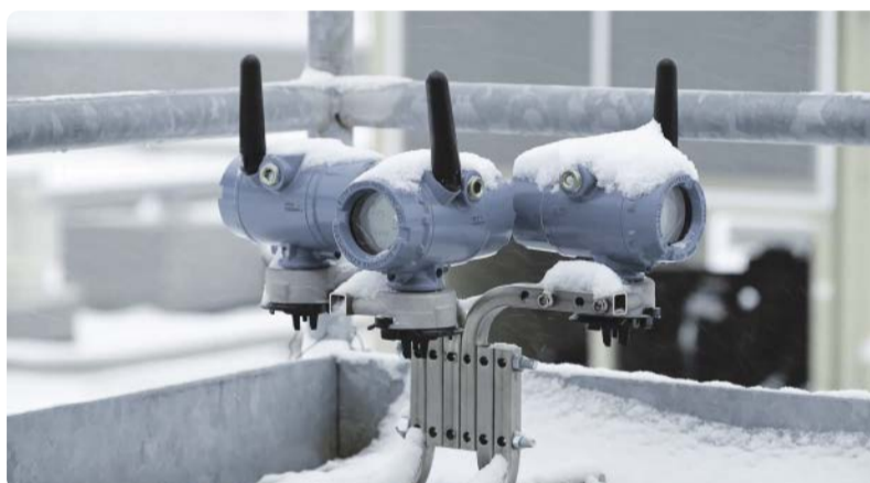
WirelessHart-Gasmonitore wie der Rosemount 928 können schnell und ohne Verkabelungsaufwand in der Anlage hinzugefügt werden.
