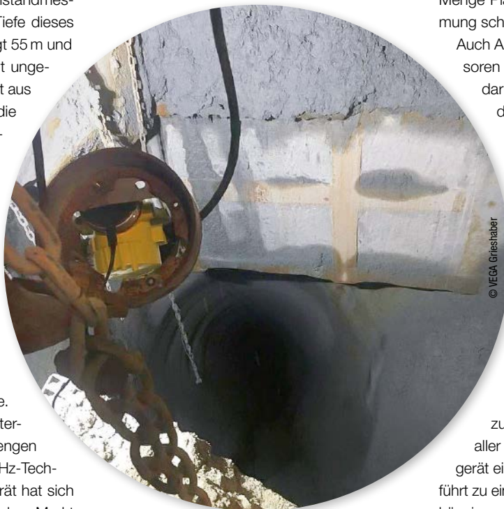
Staub, Schmutz und Lärm ergeben eine anspruchsvolle Umgebung für die Füllstandmessung in der Goldmine.
