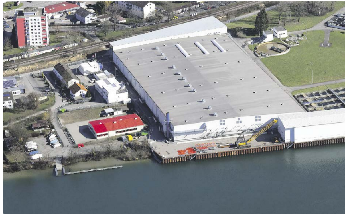
Luftaufnahme der Sanierungseinhausung sowie des temporären Schiffsanlegers für den Abtransport des belasteten Erdreichs in Spezialtransportcontainern.
