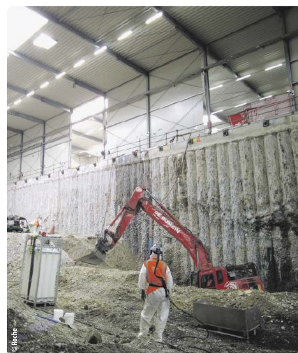
Systematischer Aushub der insgesamt 1.800 analytisch erfassten Quadranten innerhalb der insgesamt drei Baufelder.
