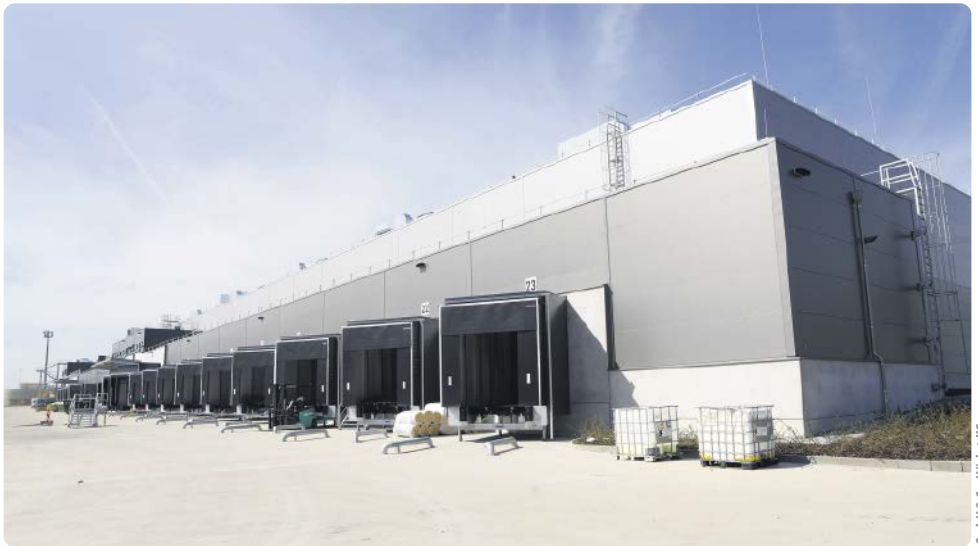
Das neue Gefahrstofflager im Industriepark Höchst setzt Maßstäbe in Bezug auf Sicherheit und Effizienz.
