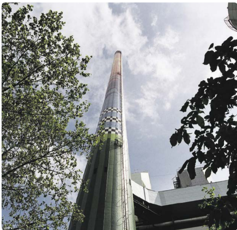
Im IP Höchst wird ein Millionenbetrag für den Umbau des Heizkraftwerks investiert.
