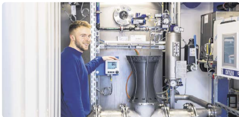
Abwasseroxidation mittels Ozon zur sicheren Entfernung von Medikamentenspuren aus dem Abwasser
