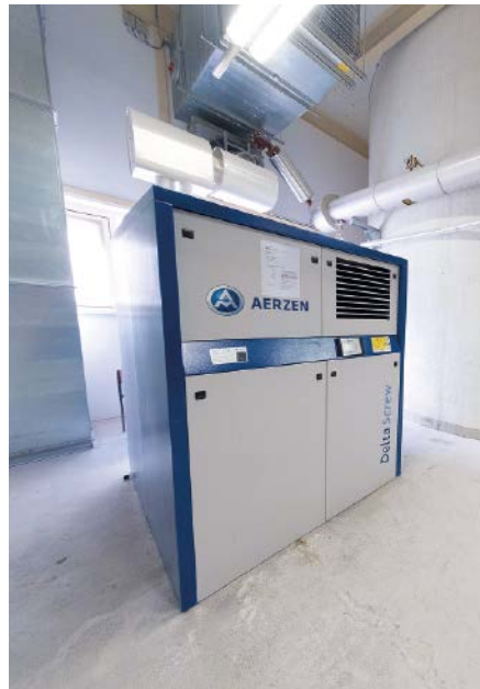
Die Delta Screw Einheiten vom Typ VM21 liefern einen Volumenstrom bis 1.200 m 3 in der Stunde.
