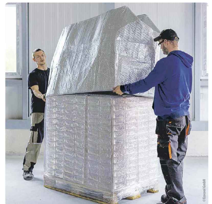
Eco-Safe+ mit Waterblankets: Die Thermohaube wird über die Waterblankets gestülpt, die ihrerseits die zu schützende Ware abdecken.
