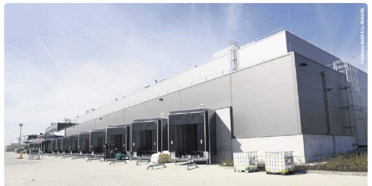
Das neue Gefahrstofflager im Industriepark Höchst setzt Maßstäbe in Bezug auf Sicherheit und Effizienz.
