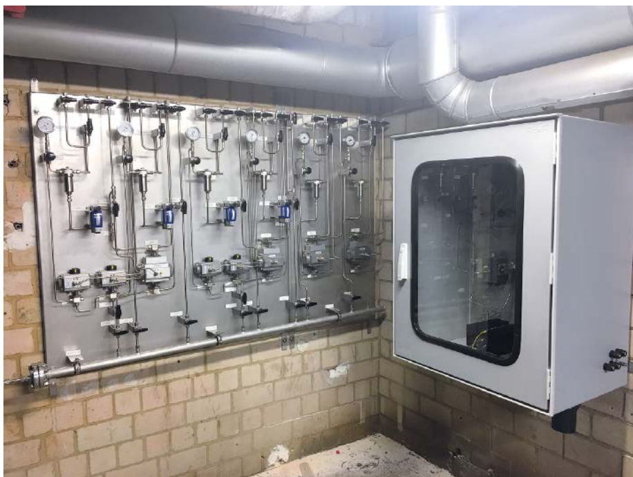
Varianten des Probennahmesystems für flüssige Proben – beheizt im Schrank (rechts) und unbeheizt auf Edelstahlplatten (links).
