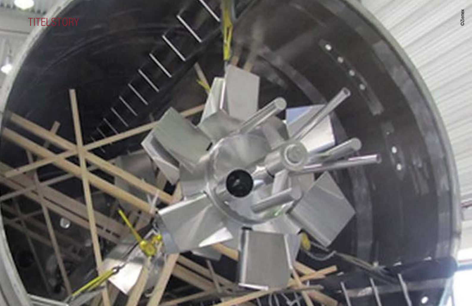
Großfermenter während der Montage – Einbau eines modernen Rührsystems bei dem französischen Behälterbauer Ziemex.
