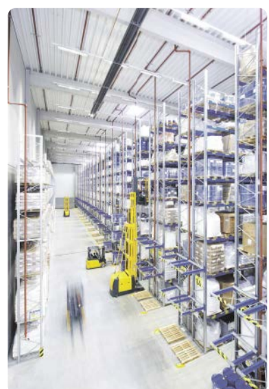
Blick in den Chemikalienlagerbereich im Multicube Rhein-Neckar in Heddeshheim
