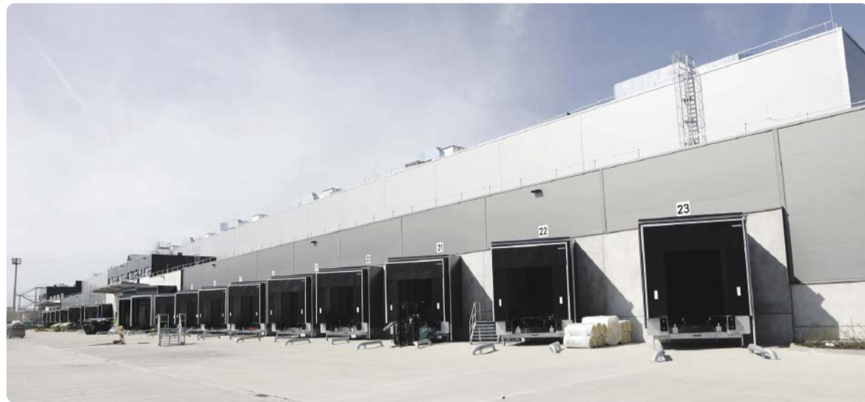
Das neue Gefahrstofflager steht. Die letzten Infrastrukturmontagearbeiten werden derzeit abgeschlossen.
