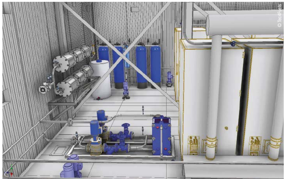
Ansicht der geplanten Versorgung mit Kühlwasser (vorne), die Gasaufbereitung (seitlich an der Wand) und die Prozesswasseraufbereitung (hinten an der Wand).
