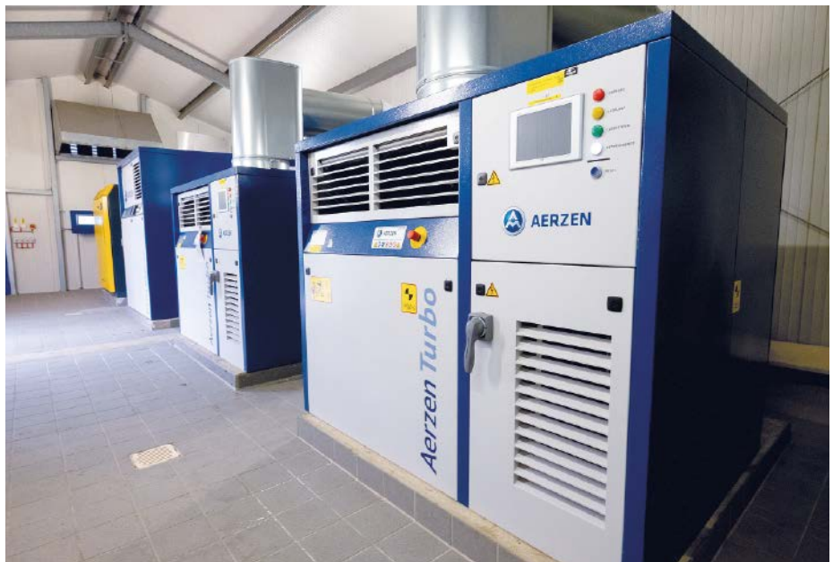
Mit der Kombination aus zwei Turbogebbläsen und einem Schraubengebläse deckt die Kläranlage Bergheim-Kenten den Luftbedarf der Biologie besonders effizient ab.
