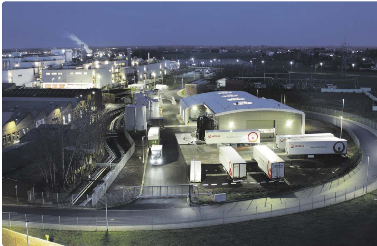
Mobile Wasseraufbereitung: Hier werden Ionenaustauscherharze regeneriert.
