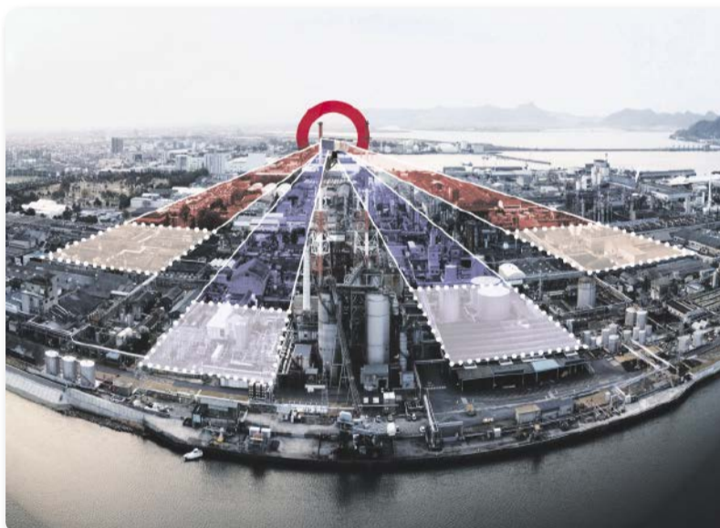
Scanfeld ist das erste Frühwarnsystem für das flächendeckende Emission Monitoring von einzelnen Prozessanlagen bis hin zu ganzen Chemieparcs.
