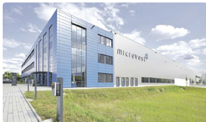
Im brandenburgischen Ludwigsfelde entwickelte Panattoni eine Produktionsanlage für den Anbieter von Energiespeichersystemlösungen Microvast mit einer Lager- und Produktionsfläche von knapp 16.000 m 2 .
