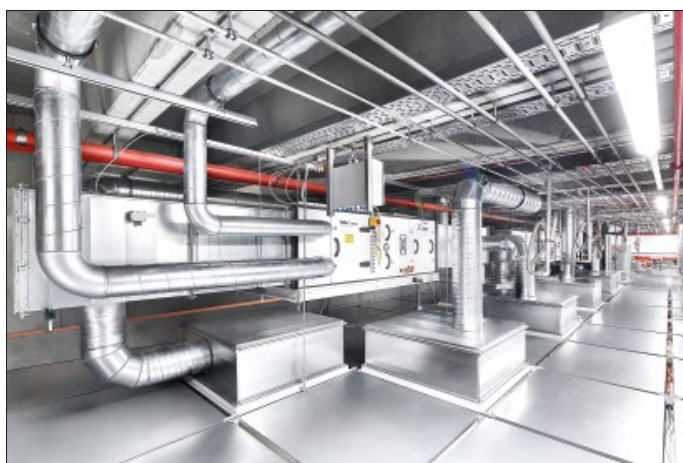
Abb. 2: Das Lüftungssystem X-Cube CROFCU (Clean Room Fan Coil Unit) ist eine besonders wirtschaftliche Lösung für Reinnräume.
