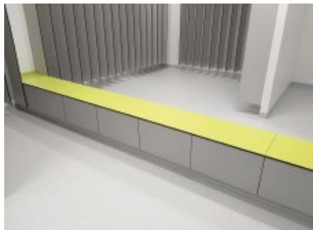
**Abb. 2: Im Reinraumbereich gelten strengste Hygieneanforderungen – daher erwies sich der für ISO-3- sowie GMP-Klasse A-Reinräume zertifizierte Objektbelag aus der Mipolam Biocontrol Familie als ideale Lösung.**
