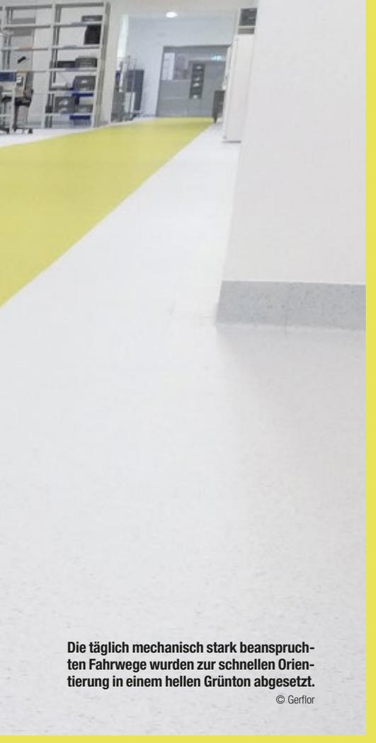
Die täglich mechanisch stark beanspruchten Fahrwege wurden zur schnellen Orientierung in einem hellen Grünnton abgesetzt.
