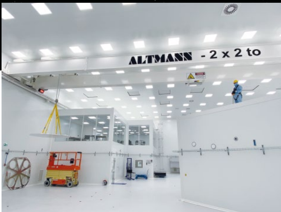
Abb. 2: Reinraumkran im Einsatz
