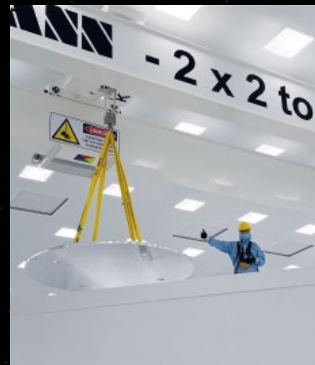
Abb. 3: Reinraumkran im Betrieb
