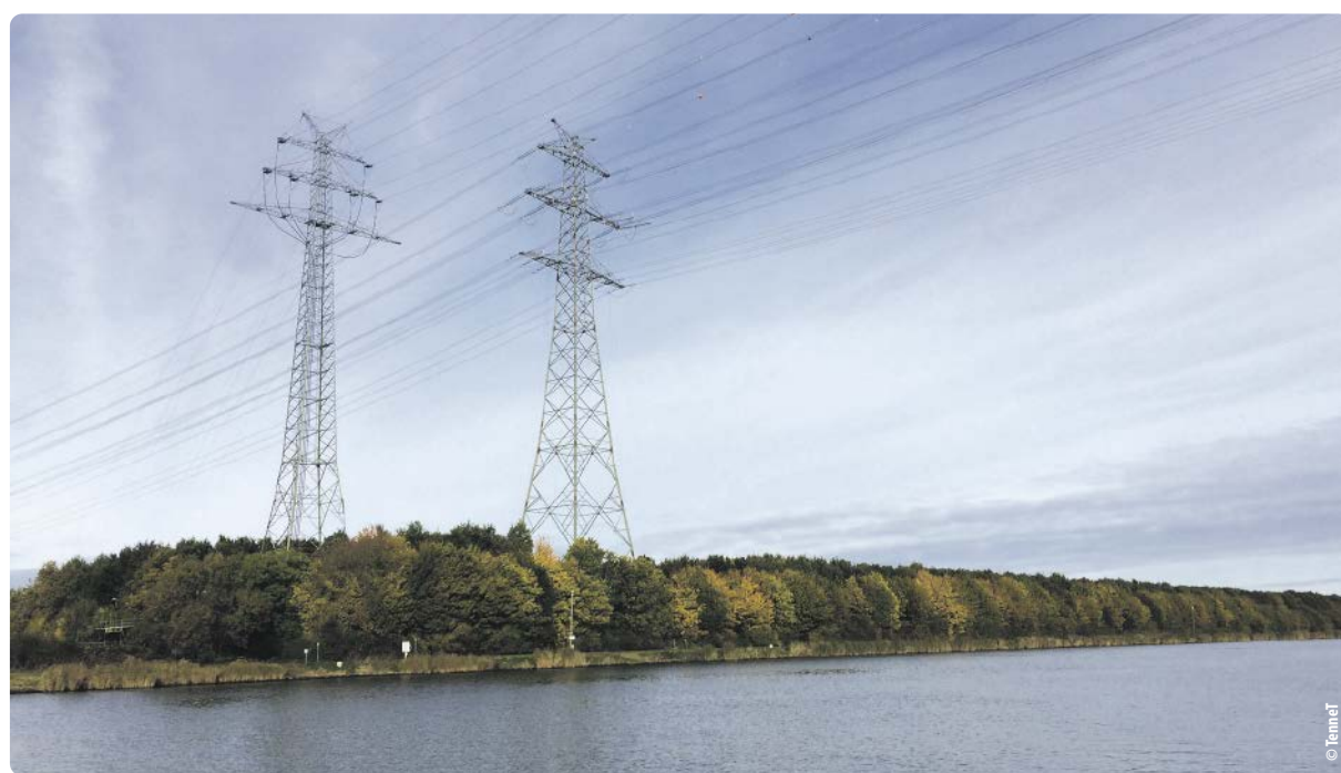
Westküstenleitung über den Nord-Ostsee-Kanal in Brunsbüttel (2016)
