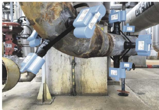
Korrosion und Erosion gehören zu den vorrangigen Herausforderungen in der Öl-, Gas- und Prozessindustrie - sie sorgen für ungeplante Ausfälle und mindern die operative Leistung. Emerson bietet ein umfangreiches Portfolio für die Korrosions- und Erosionsmessung im Rahmen seines Plantweb Ökosystems.
