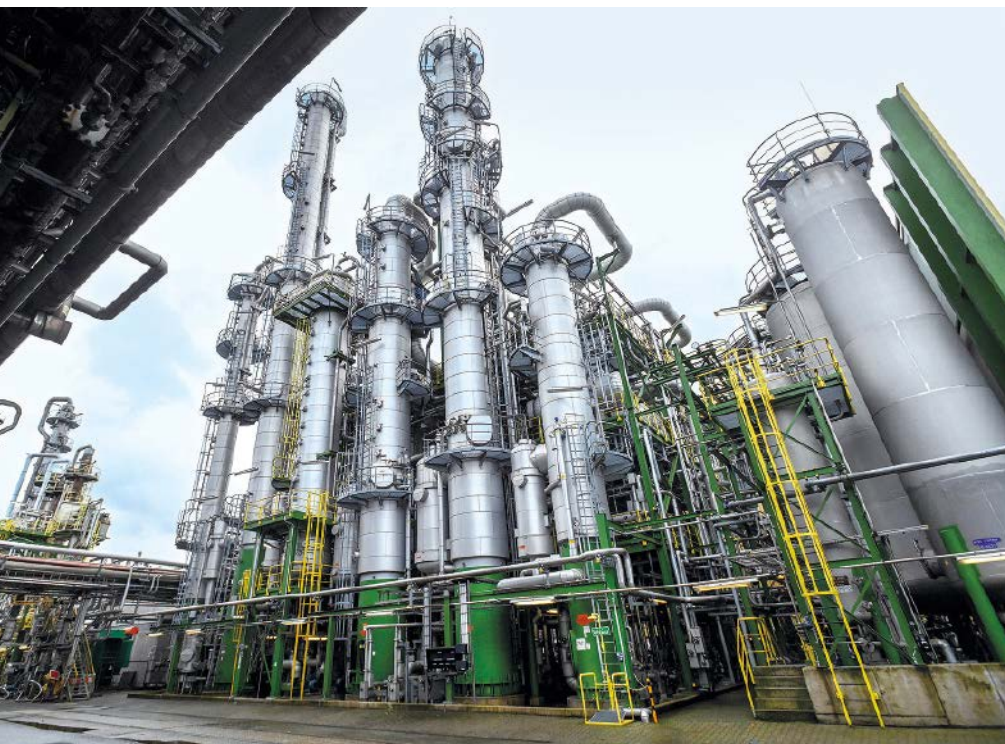
OQ Chemicals stellt in den Reaktoren in Oberhausen Oxo-Zwischenprodukte und Oxo-Derivate her. Diese Produkte entstehen auf dem Wege der Hydroformylierung: Petrochemische Ausgangsstoffe – vor allem Ethen und Propen – reagieren mit Kohlenmonoxid und Wasserstoff zu Aldehyden. Diese werden von Industriekunden zu Spezialchemikalien veredelt.
