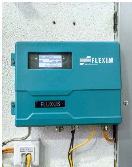
Als Messumformer kommt der stationäre Fluxus G721 ST-LT mit Druck- und Temperaturkompensation zum Einsatz.
